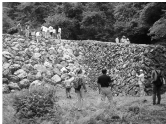
■ 見事な石積みの堰堤に登る
