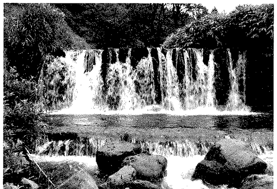
写真-14 大河内砂防上えん堤
