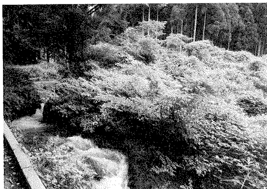
写真-5 1998年8月撮影の八号えん堤
