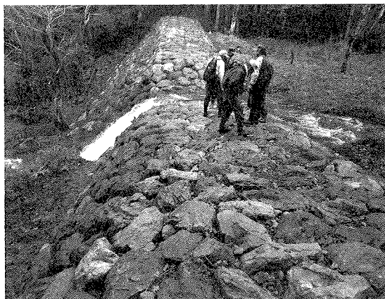
写真-16 大鶴目川砂防シジャミえん堤
