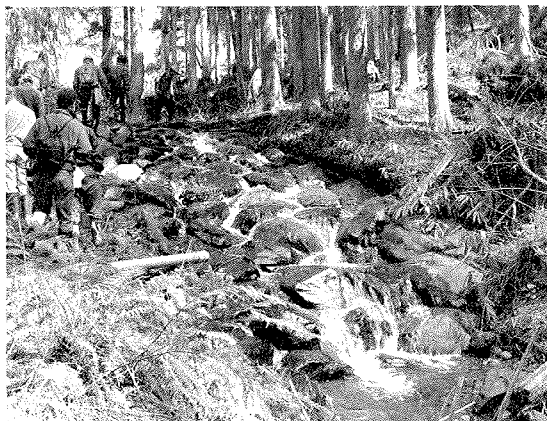
写真-15 広野砂防ニオダン斜路工（床固工）
