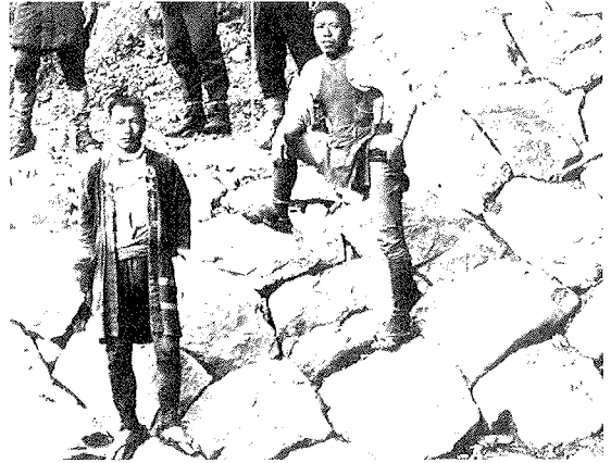
写真-4 大正9年大谷川砂防工事（古木某氏提供）
