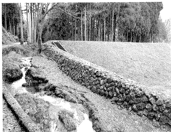
写真-6 2009年1月撮影の八号えん堤
