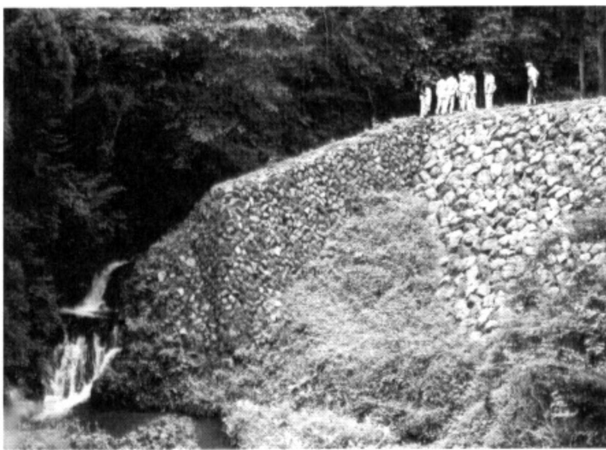
図-2 岩盤を利用したアカタン砂防戸の東堰堤
