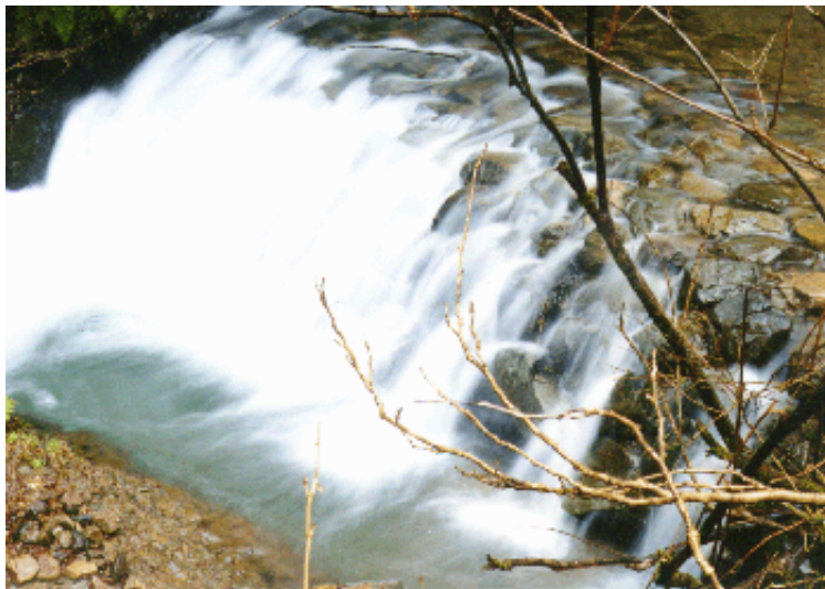
赤谷川7号石組み堰堤の階段状の美しい水通しの一つ
