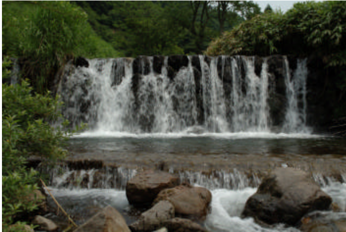
美しい自然石の野面積み砂防堰堤 (大河内川砂防上堰堤)
